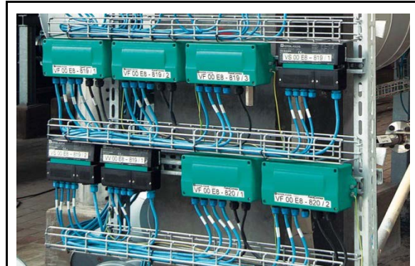
Abbildung 20: Feldbusinstallation in Kabeltrassen
